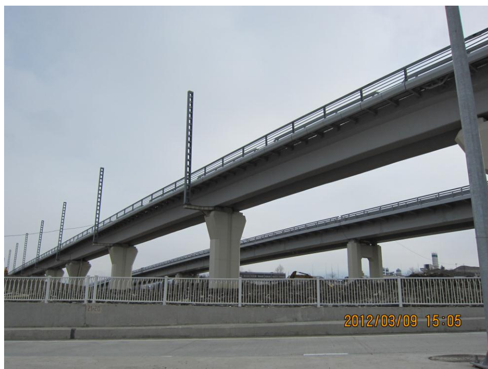
図表 24 鉄道建設現場
