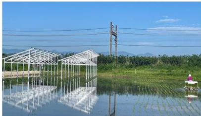
水田での杭架台の標準化
