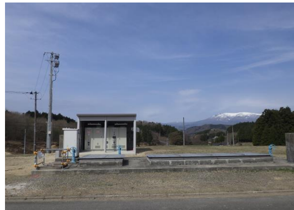
水車発電機連系盤建屋
