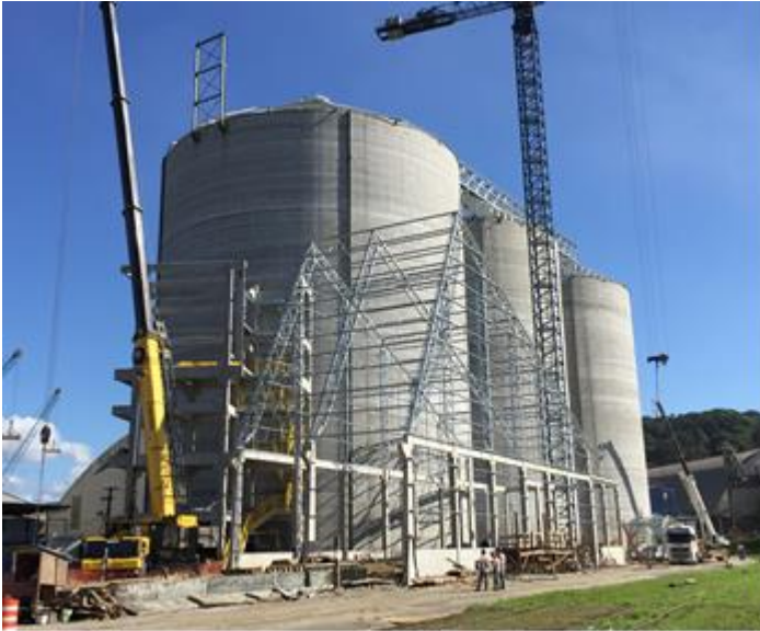
増設工事中のサイロ
