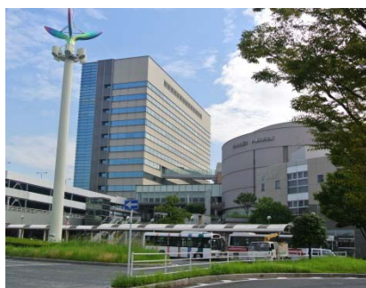
「北九州センター」外観
