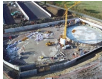
建設中のバイオメタン生産プラント（英国）
