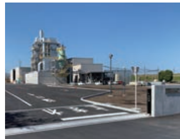
ごうどバイオマス発電所（岐阜県）
