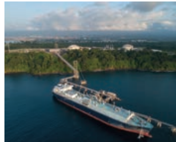
EG LNGプロジェクト（赤道ギニア）
