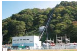
第一・第三発電所
