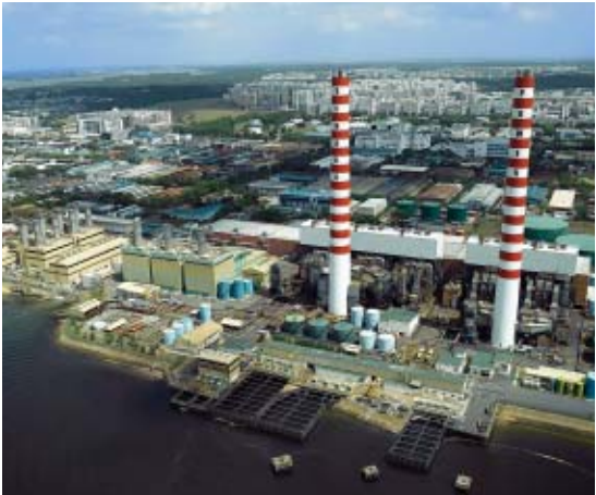
セノコ・パワー・リミテッド社の発電所
