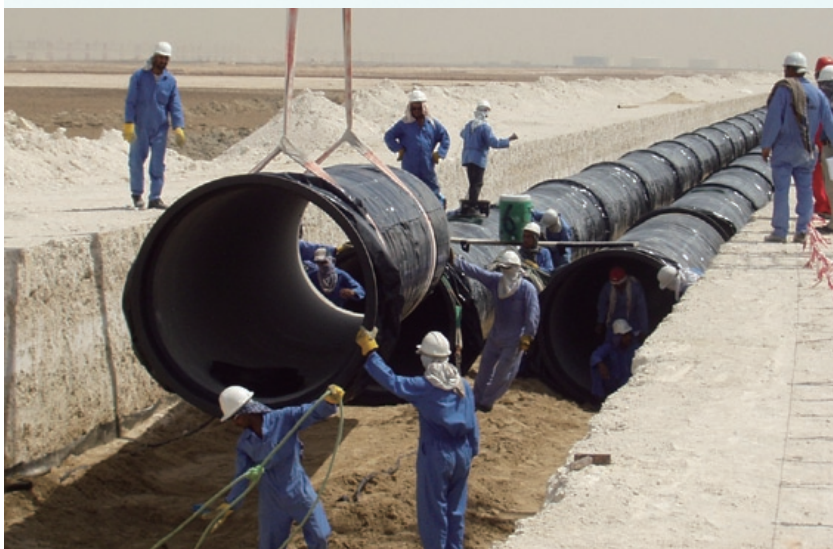
UAE・アブダビ市のシュワイハット送水管敷設プロジェクト
