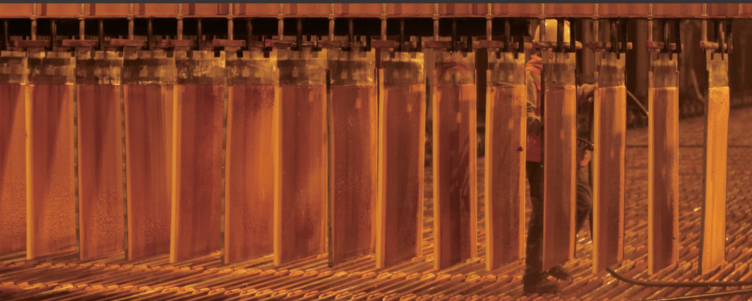
エルテソロ銅地金精錬工場
