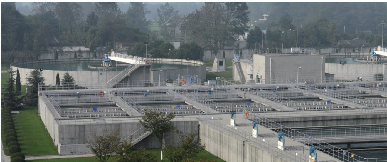
中国・四川省成都市向け上水供給BOT案件 成都市浄水処理プラント
