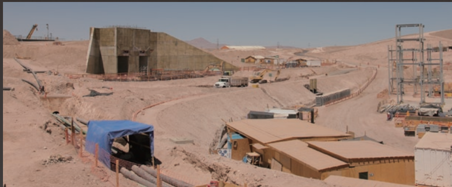
建設当時のエスペランサ銅鉱山運鉱エリア
