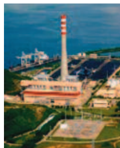
バグビラオ火力発電所
