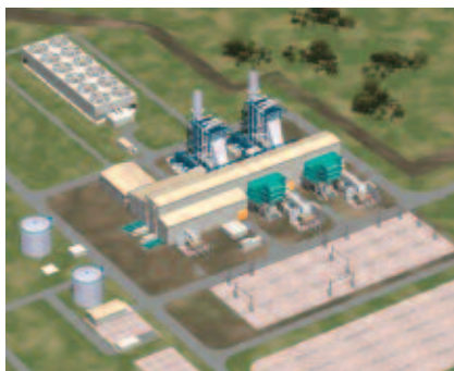
バンパコン複合火力発電所
