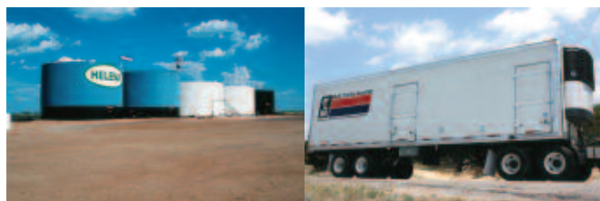
(左) Helena Chemical社のタンク設備 (右) MAC Trailer Leasing社の冷凍冷蔵トレーラー
