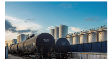
カリフォルニア工場のオイルタンクとオイル輸送レールカー
