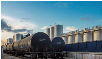
カリフォルニア工場のオイルタンクとオイル輸送レールカー
