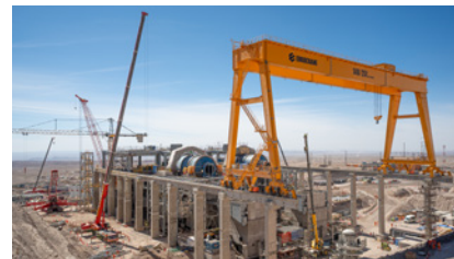
チリ・センチネラ銅鉱山ボールミル（建設中）
