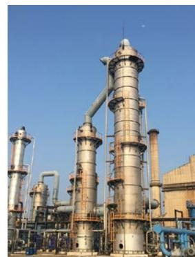
英国Carbon Clean社のCO<sub>2</sub>分離・回収技術を利用した設備
