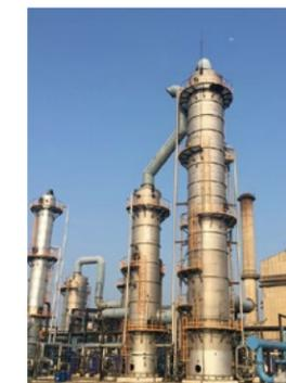
英国Carbon Clean社のCO<sub>2</sub>分離・回収技術を利用した設備
