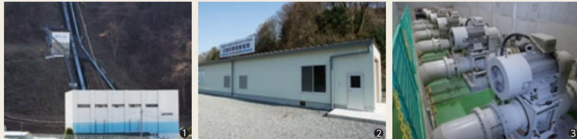
①第3発電所(写真上)の発電に使用された水は、第1発電所(写真下)の冷却水として再利用される
