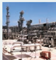
LNG Project (Qatar)
