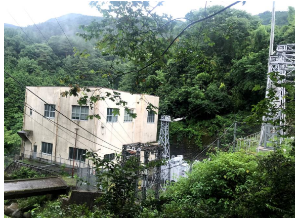
小鹿第一発電所
