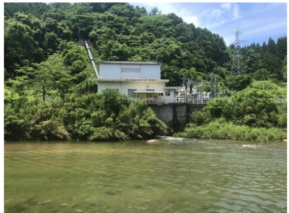
日野川第一発電所
