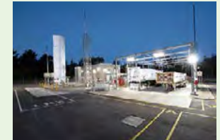
水素・燃料アンモニアサプライチェーン構築事業 (水素液化設備・積荷基地 (HEA社提供))
