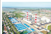
Jawa1 ガス焚き火力発電事業 (ガス焚き火力発電所および洋上LNG貯蔵・ 再ガス化設備(FSRU)) (インドネシア)
