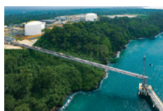
LNG液化設備
