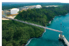
LNG液化設備
