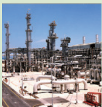
LNG project (Qatar)
