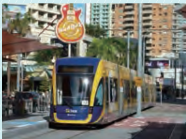
ゴールドコースト市におけるトラムシステム 建設・運行・保守事業 (豪州)
