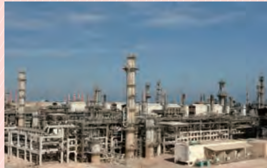
世界屈指の規模を誇るカタールLNGプロジェクト (カタール)
