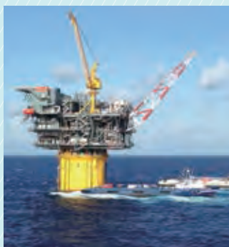
メキシコ湾で稼働中の SPAR型プラットフォーム (米国)
