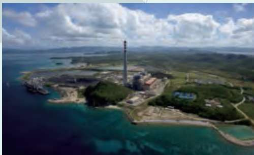
パグビラオ石炭火力発電所 (フィリピン)
