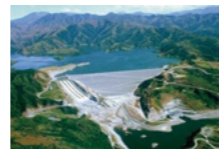
San Roque水力発電事業(フィリピン)
