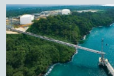
LNG液化設備
